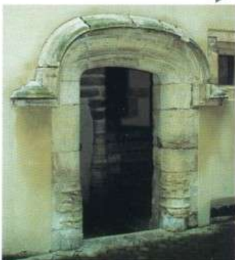
▲ COEUR D'ÎLOT PLACE VOLTERRA
